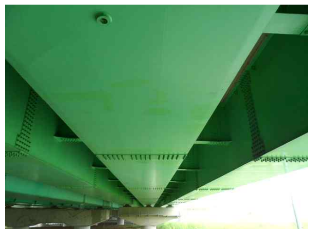
거더외부 S2 상태양호
