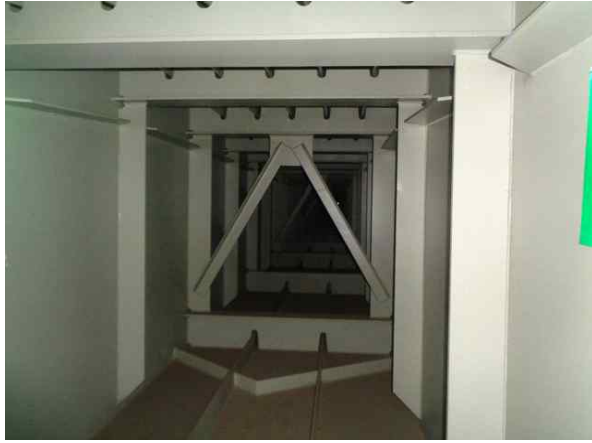
거더내부 S1 상태양호
