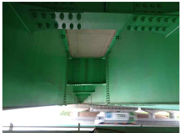
가로보 S4 상태양호
