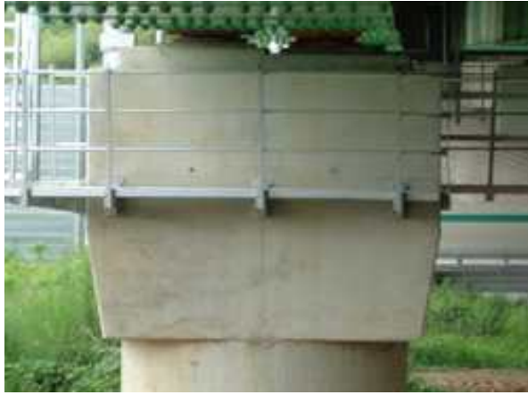
교각 P3 코핑부 상태양호
