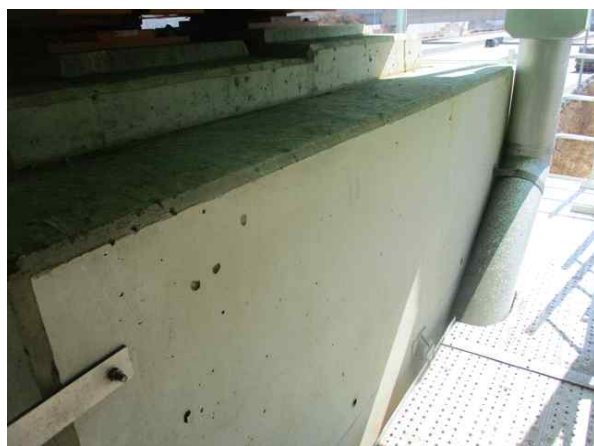
교각 P1 코핑부 상태양호
