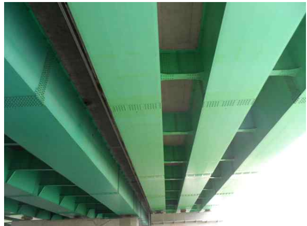
가로보 S2 상태양호
