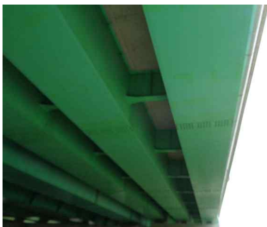
거더외부 S1 상태양호
