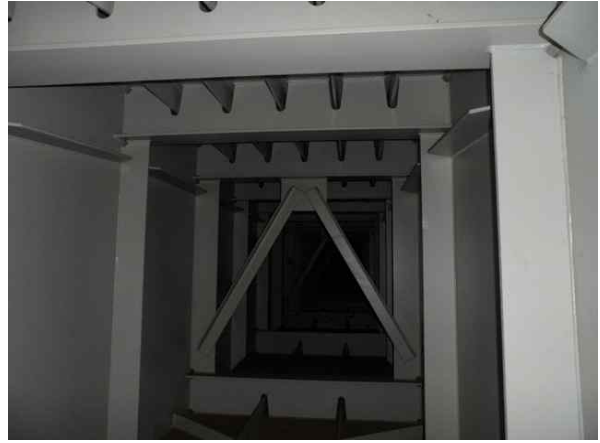
거더내부 S4 상태양호
