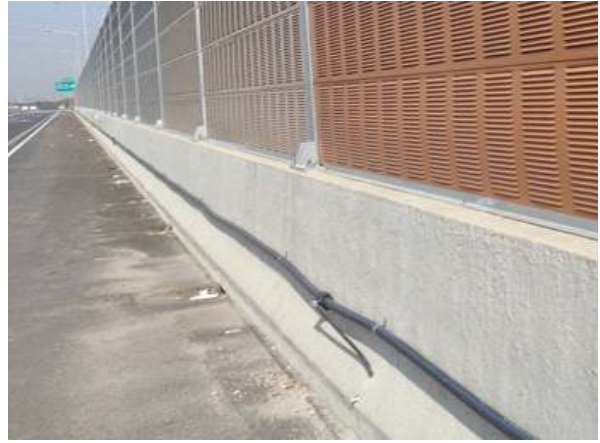
방호벽 S2 상태양호
