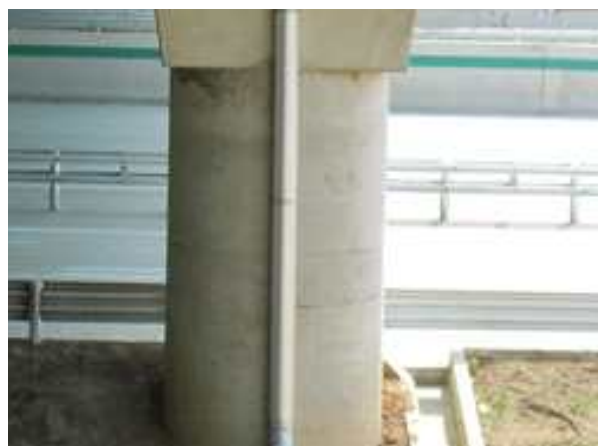
교각 P1 기둥부 상태양호
