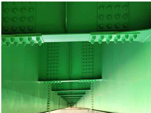
가로보 S3 상태양호
