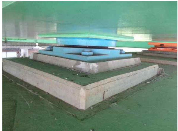
교량반침 P2-Sh3 상태양호
